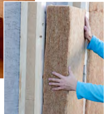
Außendämmung: THERMO FASSADE mit THERMO JUTE 100
