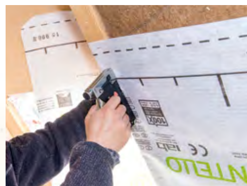
Wichtig ist der fachgerechte Einbau der Luftdichtungsbahnen.
