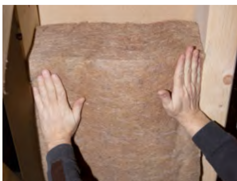
Für eine Klemmwirkung werden die Matten mit Übermaß eingebaut.
